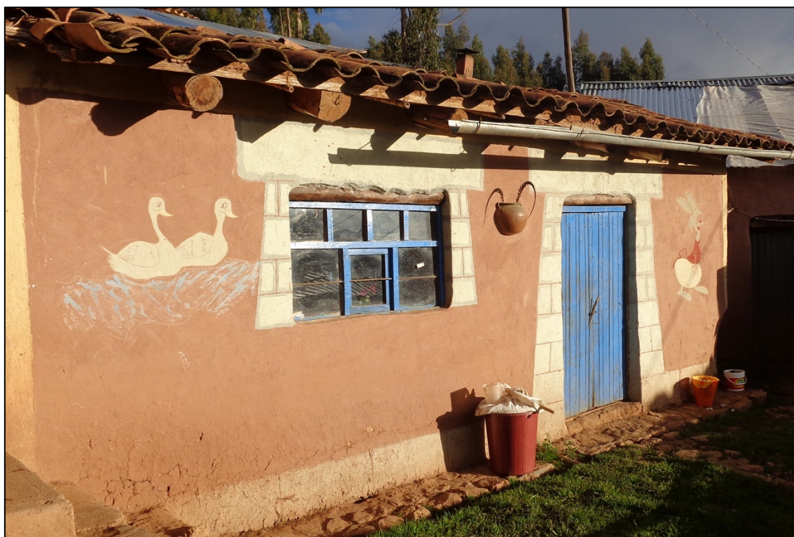
Image 11 : façade d'une des maisons lauréates du concours en décembre 2014
