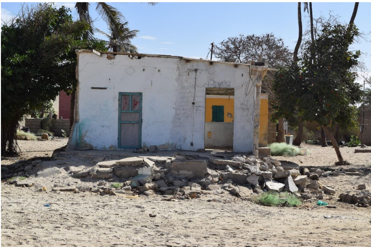
Dégâts causés par les submersions marines à Gandiol sur la plage de Tassinère, janvier 2017 Source : Loïc Brüning
