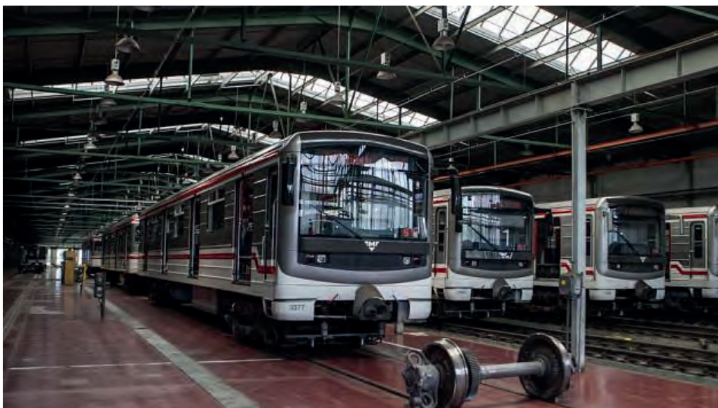
Illustration 80 : aperçu du paysage intérieur typique d'un hangar de métro.
