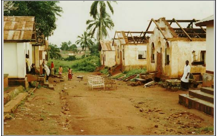
Fig. 23 : Les bâtiments en rénovation (Photo de l'auteur, 2003)
