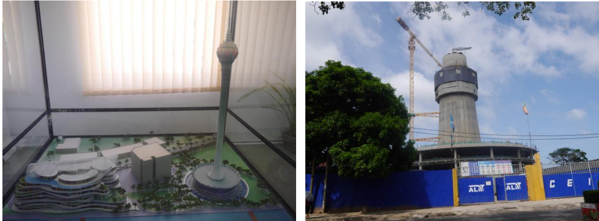
Figure 24: Maquette et construction de la « Lotus Tower »
