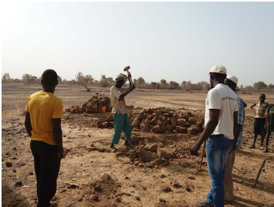
Figure 7 : Déterrage des moellons (Jeanne Pittet, 01.18)
