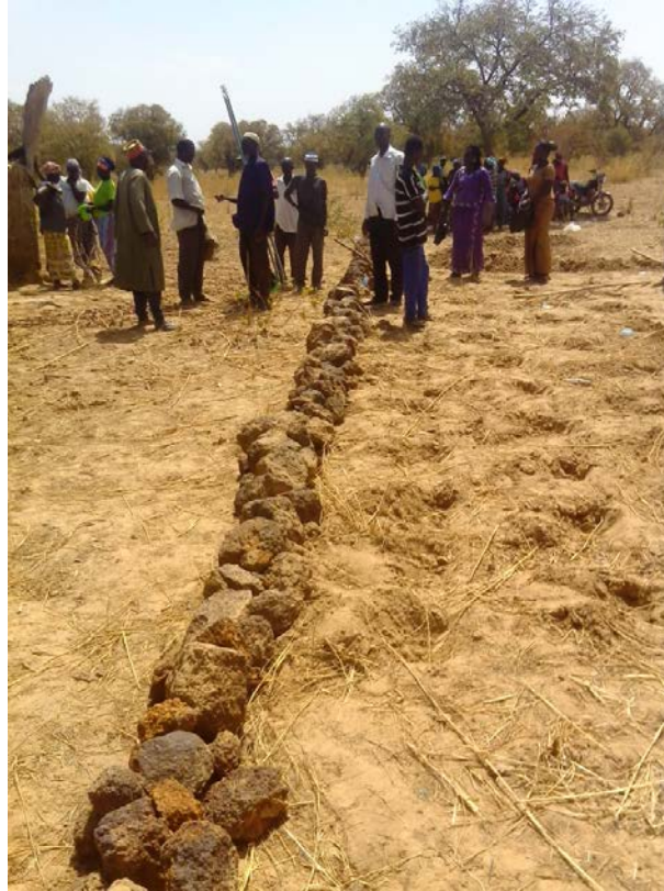
Figure 9 : Mise en place des cordons pierreux le long des courbes de niveau (Jeanne Pittet, 02.18)
