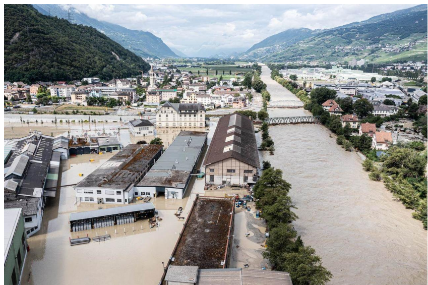
Figure 1 : Débordement du Rhône à Chippis (RTS, 2025)
