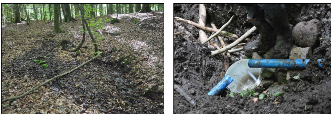
Figure 8: Pseudo-source de l'arbre tordu et point de réunion des deux drains (Seau).
