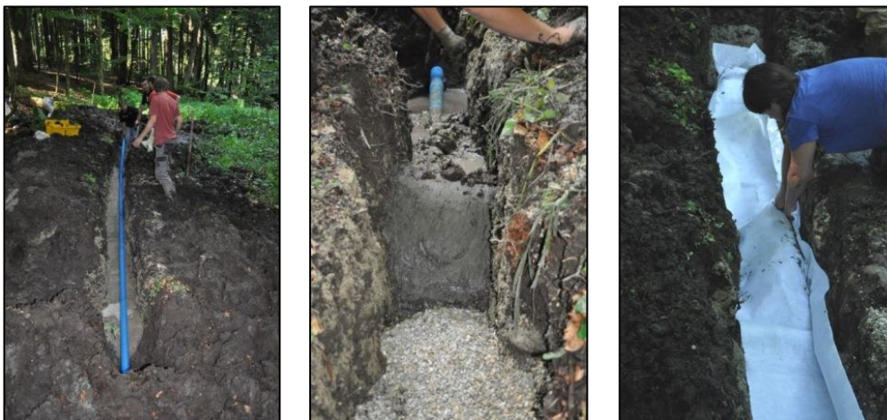
Figure 7: Réalisation des drains : de gauche à droite, tranchée, bouchon d'argile et géotextile.
