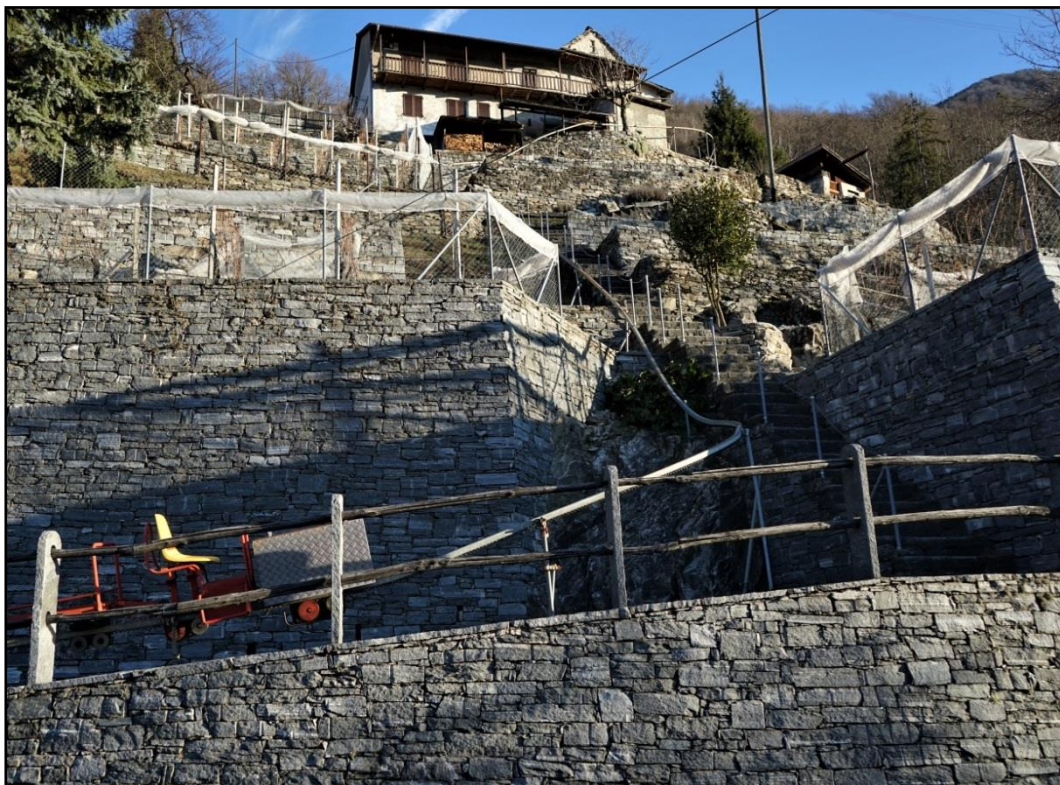
Fig. 14 : Carrello su binario per portare il materiale dalla strada a una casa nel nucleo di Loco. (Foto personale)
