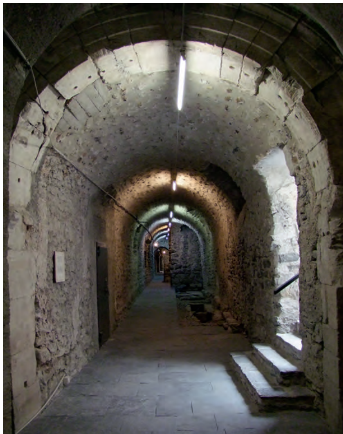
Couloir d'accès (catacombes) de la 4 e église.
